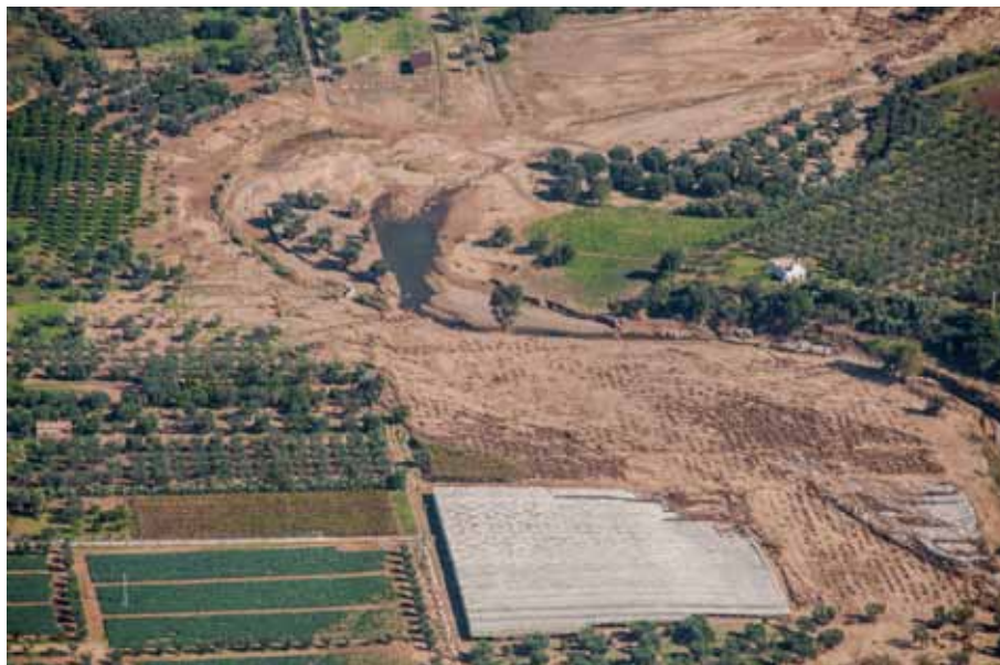
Foto 7 - Agro di Ginosa – Località Bandiera (Torrente Vallone della Rita). Evidenti i danni alle strutture agricole costruite nel letto di esondazione nel tratto meandri-forme del corso d’acqua (Foto G. D’Onofrio).
